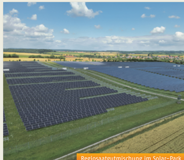
Regiosaatgutmischung im Solar-Park
