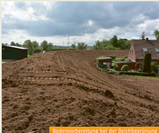
Bodenvorbereitung bei der Deichbegrünung
