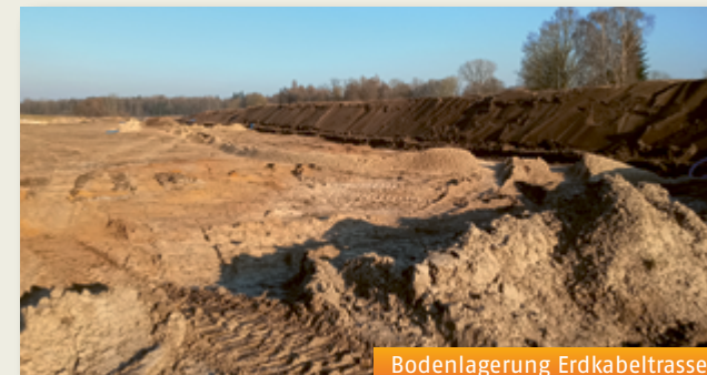
Bodenlagerung Erdkabeltrasse
